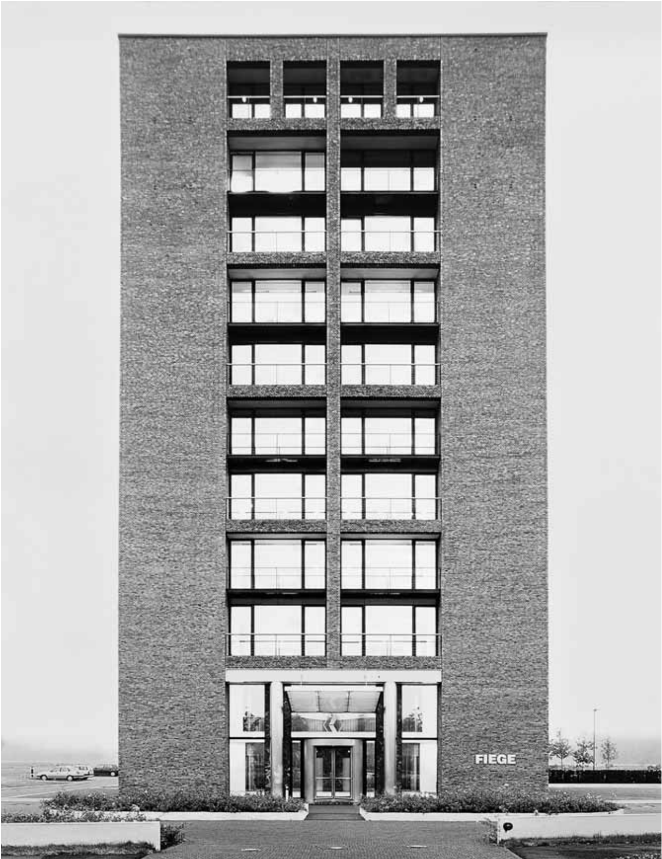
Erste Ansiedlung im AirportPark FMO | Systemzentrale Fiege, Architekt Prof. Josef P. Kleihues mit Norbert Hensel
